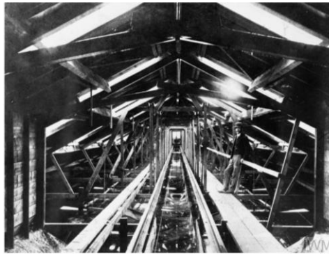
Figura 5 - Tanque de Froude (1872)
