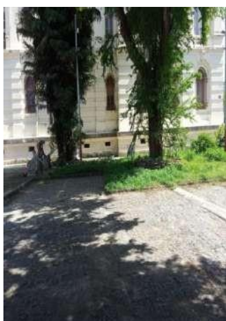
LOCAL: CCJ SITUAÇÃO: ANTES
